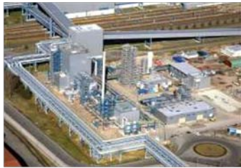
Vattenfall Schwarze Pumpe Deutschland - 30 MW th Oxy - Braunkohle
