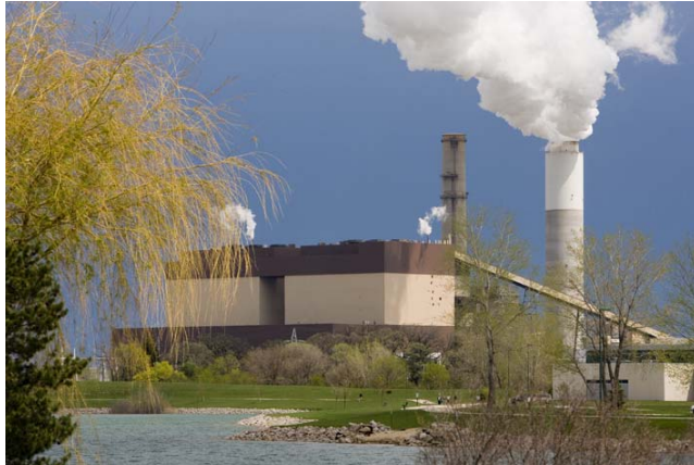
Kraftwerk Pleasant Prairie ("P4"), Wisconsin
